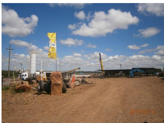
Ilustración 7 – Obrador principal Acopio de materiales varios
