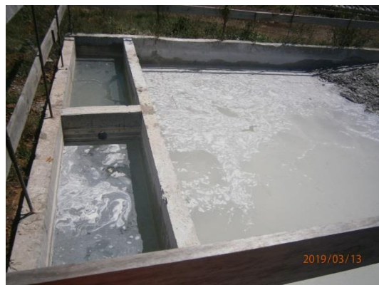
Ilustración 12 – Obrador Principal Pileta de lavado de camiones
