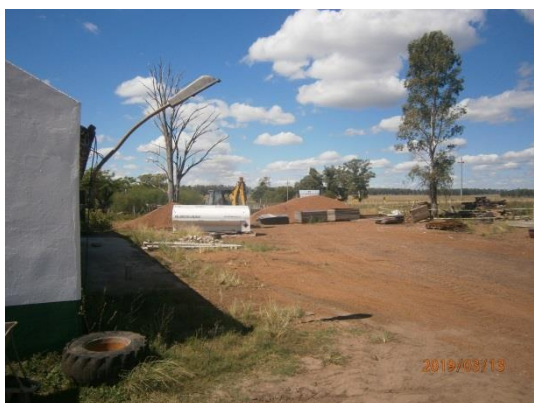
Ilustración 15 – Obrador de CUJÓ-INCOCI propiedad de vialidad
