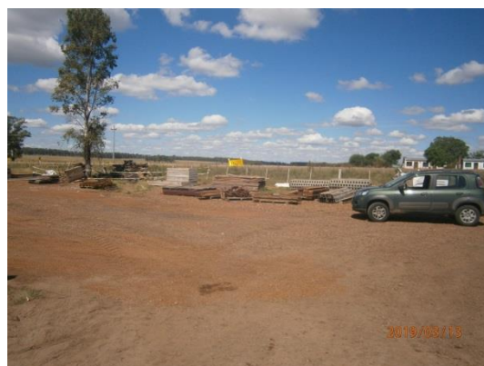
Ilustración 16 – Obrador de CUJÓ-INCOCI propiedad de vialidad
