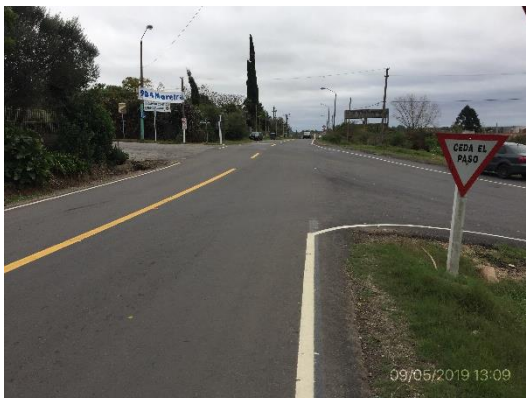
Ilustración 9 – Tramo de obras terminadas en Rosario con recuperación ambiental realizada
