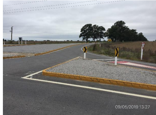
Ilustración 12 – Tramo de obras terminadas en empalme de Ruta 2 y Radial Nueva Helvecia con recuperación ambiental realizada.
