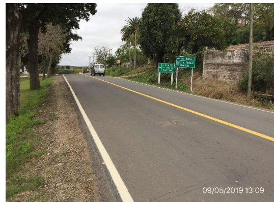
Ilustración 10 – Tramo de obras terminadas en Rosario con recuperación ambiental realizada
