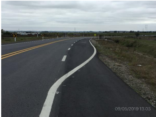
Ilustración 11 – Tramo de obras terminadas en Ruta 2 con recuperación ambiental realizada
