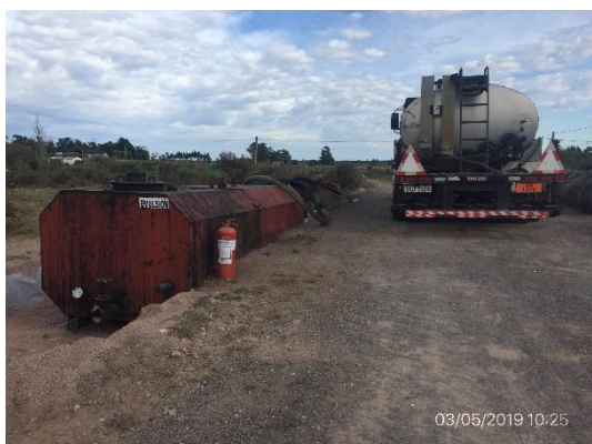
Ilustración 12 – Obrador – Depósito de emulsiones asfálticas
