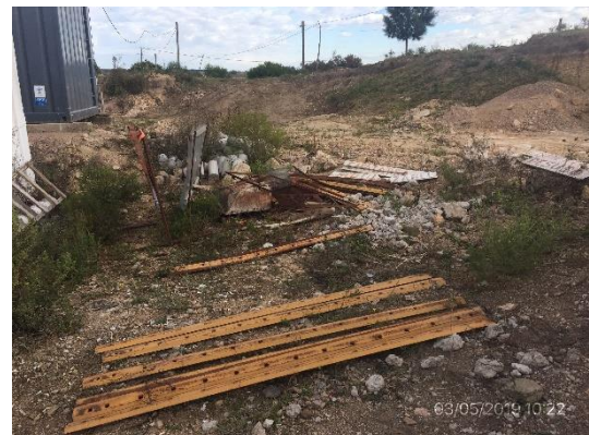
Ilustración 7 – Obrador – acopio de chatarra
