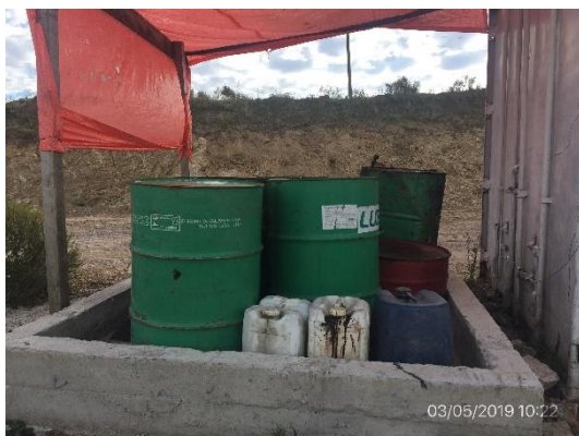
Ilustración 8 – Obrador – Depósito de lubricantes con vallado para contención
