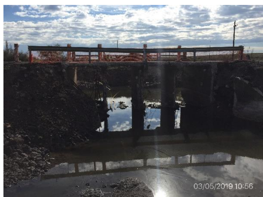
Ilustración 12 – Obra en alcantarilla sobre A° Vejigas. Trabajos en el cauce
