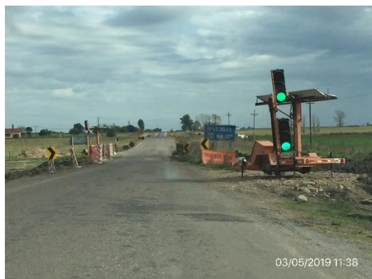
Ilustración 10 – Obra en alcantarilla sobre A° Vejigas. Tablero superior
