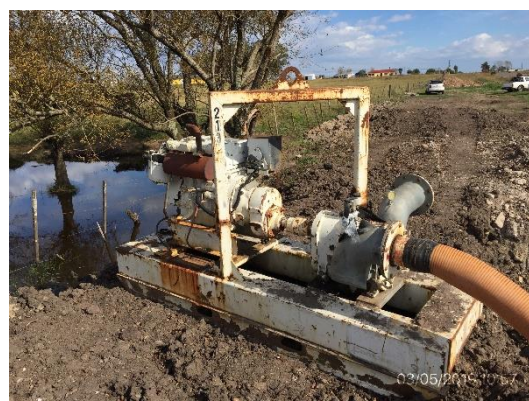
Ilustración 13 – Obra en alcantarilla sobre A° Vejigas. Motobomba para control de flujo.
