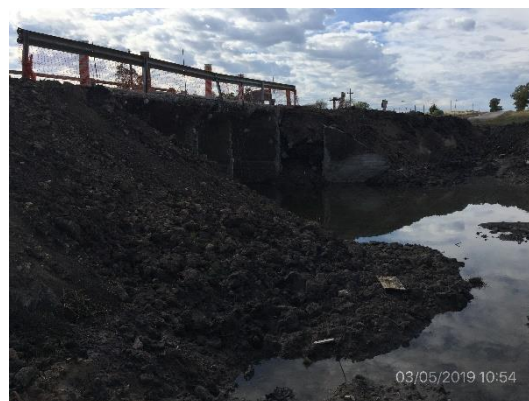
Ilustración 11 – Obra en alcantarilla sobre A° Vejigas. Trabajos en el cauce
