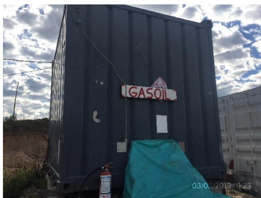
Ilustración 8 – Obrero – Tanque de gasoil con doble pared
