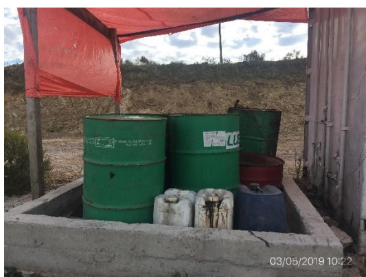
Ilustración 6 – Obrero – Depósito de lubricantes con vallado para contención
