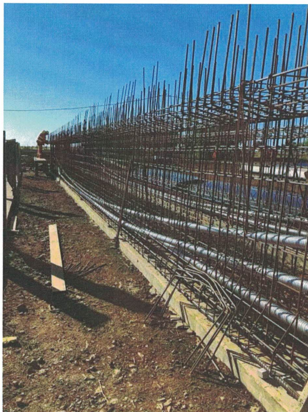
Imagen 9 y 10 – Vigas prefabricadas postensadas
