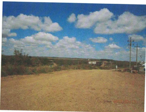
Ilustración 5 – Puente sobre el A° Cuaró desde el Obrador Principal
