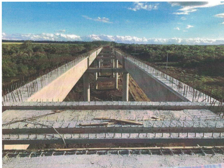
Imagen 5, 6, 7 y 8 – Izaje de Losetas prefabricadas
