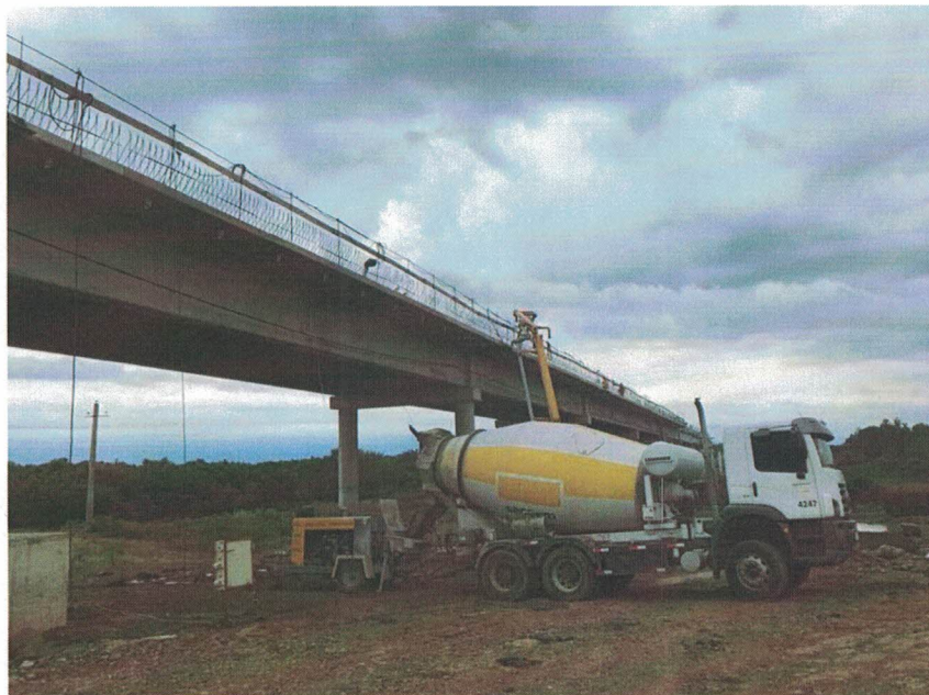
Imagen 28, 29 y 30 – Losa de tablero
