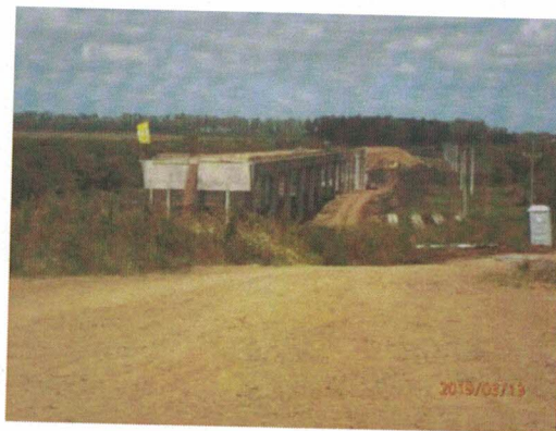
Ilustración 6 - Puente sobre el A° Cuaró desde el Obrador Principal
