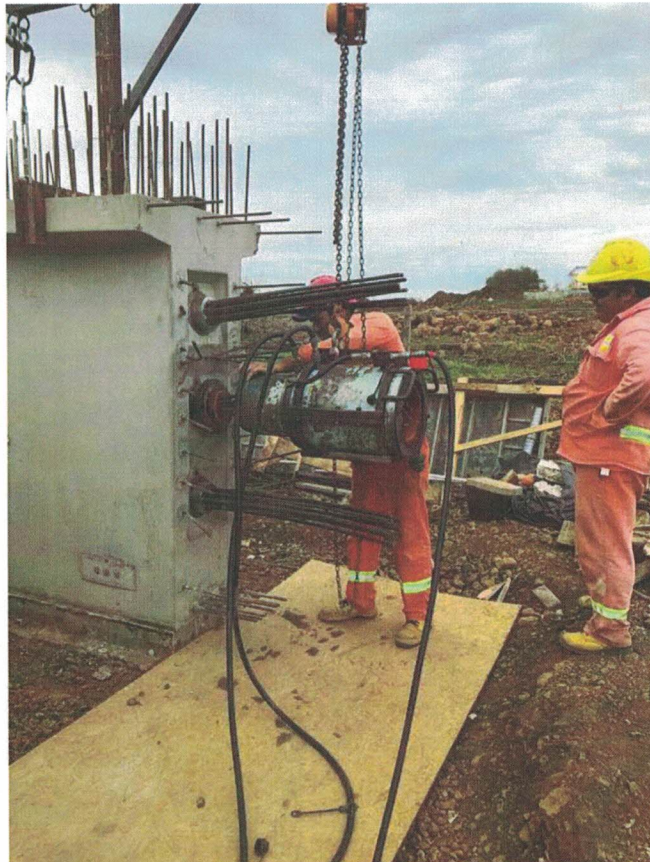
Imagen 11, 12, 13 y 14 – Tesado de vigas prefabricadas postensadas
