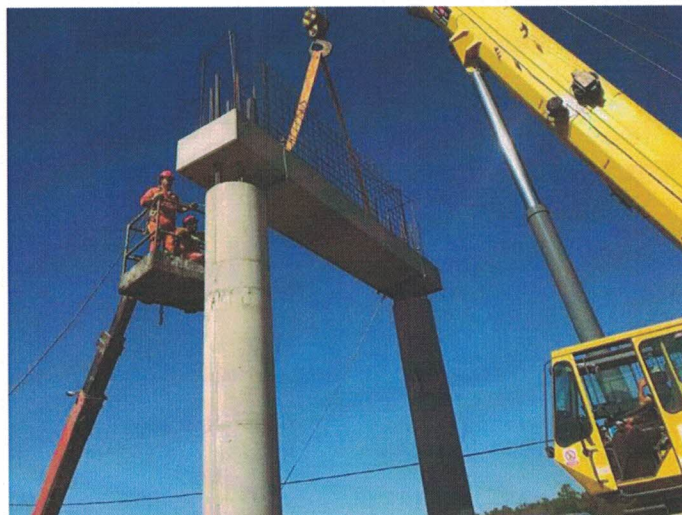
Imagen 20 y 21 – Izaje de prefabricados
