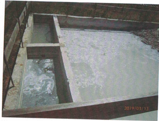
Ilustración 12 – Obrador Principal Pileta de lavado de camiones
