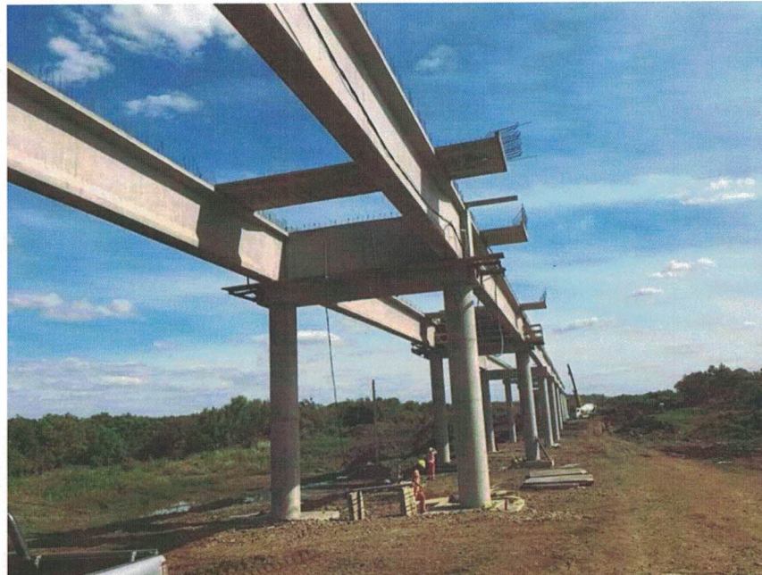
Imagen 15, 16 y 17 – Izaje de vigas prefabricadas postensadas
