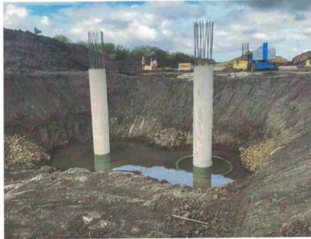
Imagen 26 y 27 – Pilares de pórticos y estribos
