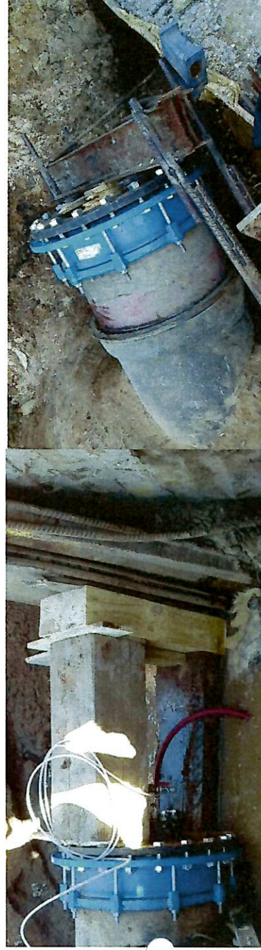
Imagen 8 y 9 – Tapones para prueba hidráulica
