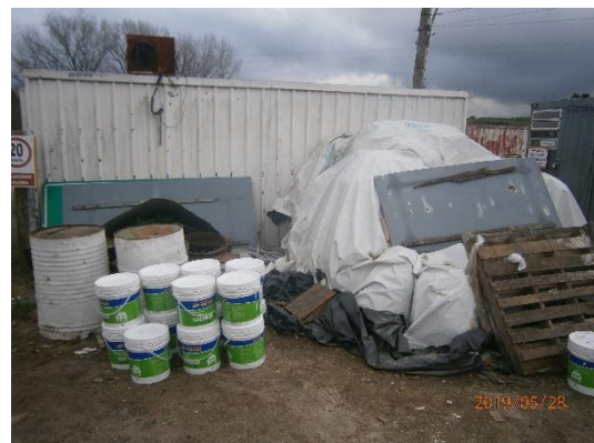
Ilustración 10 – Acopio de pinturas y materiales diversos
