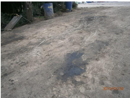
Ilustración 7 - Evidencia Zona de lavado de maquinaria sin impermeabilización, contención ni colector, manchas de hidrocarburos.
