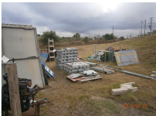
Ilustración 11 – Acopio de materiales de obra
