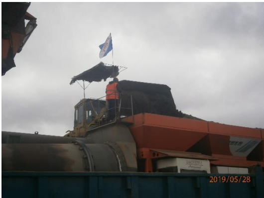
Ilustración 19 – Operación en planta de asfalto
