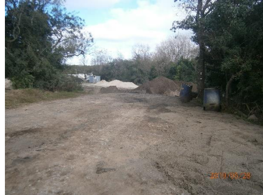
Ilustración 6 - Evidencia Zona de lavado de maquinaria sin impermeabilización, contención ni colector.
