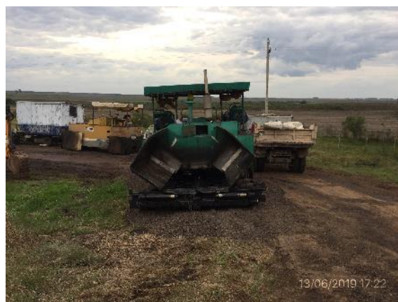
Ilustración 7 – Ruta 26 progresiva 78K100 estacionamiento provisorio de maquinaria
