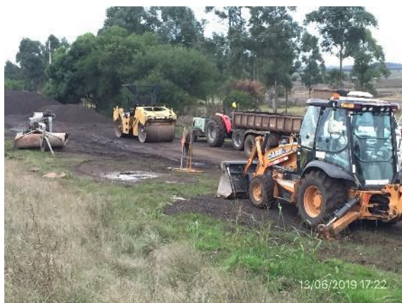
Ilustración 6 – Ruta 26 progresiva 78K100 estacionamiento provisorio de maquinaria
