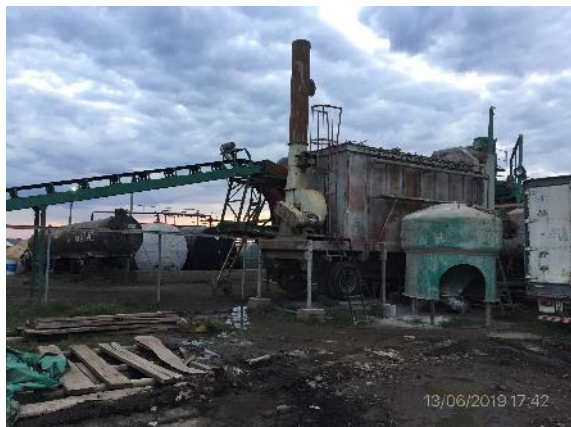
Ilustración 10 – Obrador. Planta asfáltica en proceso de desmantelado con vallados
