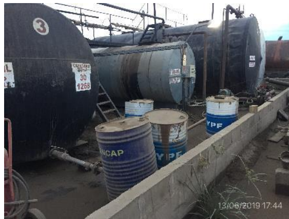
Ilustración 11 - Obrador. Planta asfáltica en proceso de desmantelado con vallados
