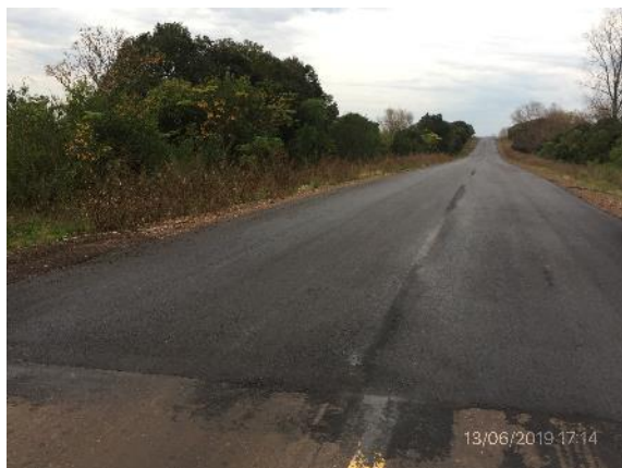
Ilustración 4 – inicio de tramo, Ruta 26 progresiva 70K000
