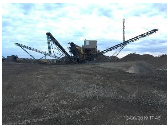
Ilustración 12 - Obrador. Planta de trituración en proceso de desmantelado
