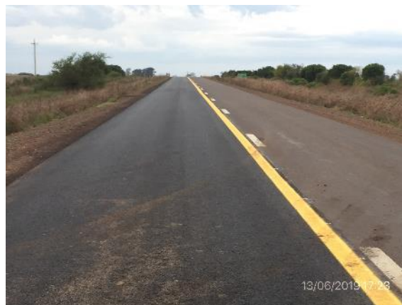
Ilustración 5 – Ruta 26 Tramo terminado
