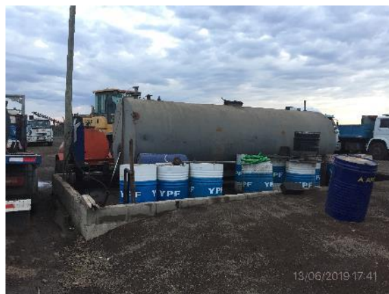
Ilustración 9 – Obrador. Acopio de lubricantes y diluidos asfálticos
