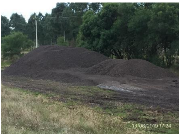
Ilustración 8 – zona de acopio en faja
