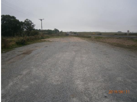
Ilustración 4 – Sector de acopio de material granular y piletas de mezcla asfáltica desmantelado con suelo compactado en faja pública.
