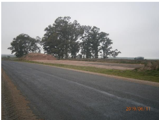
Ilustración 6 – Sector de acopio de material granular en faja pública
