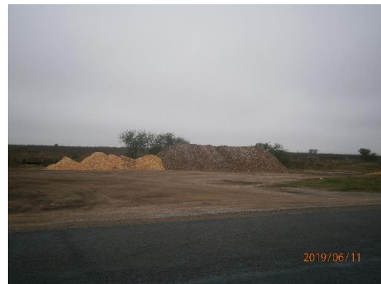
Ilustración 7 – Sector de acopio de material granular en faja pública
