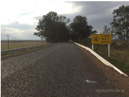
Ilustración 6 – tramo ejecutado, Ruta 26
