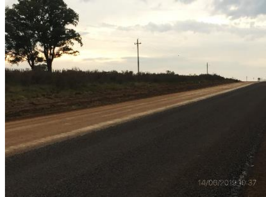
Ilustración 11 - tramo en ejecución, Ruta 26
