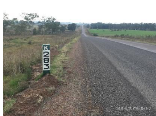
Ilustración 7 – tramo ejecutado, Ruta 26 0
