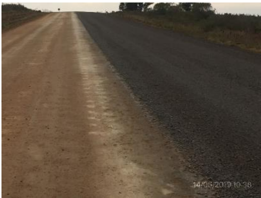
Ilustración 12 - tramo en ejecución, Ruta 26
