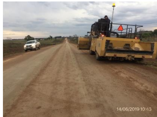
Ilustración 13 – Frente de obras, Ruta 26 progresiva 326K400
