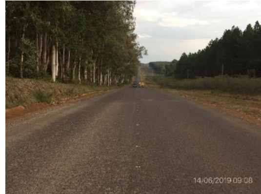
Ilustración 5 – tramo ejecutado, Ruta 26
