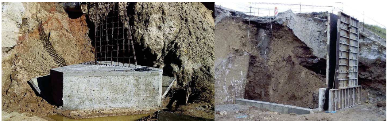
Imagen 12 y 13 – Cabezales, pilar y riostra de estribos
