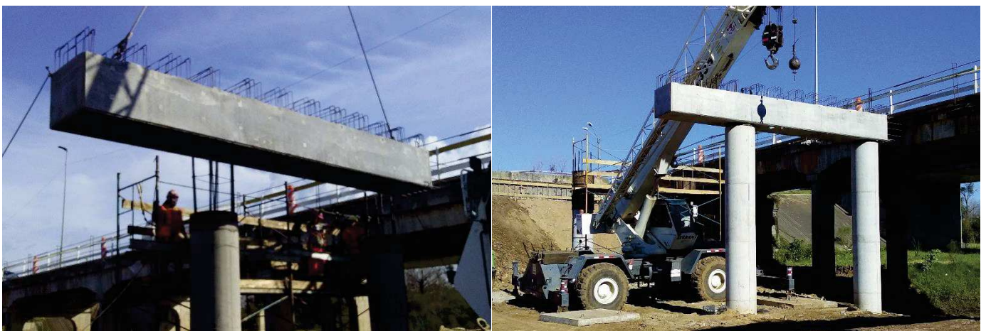
Imagen 17 y 18 – Montaje de vigas prefabricadas
