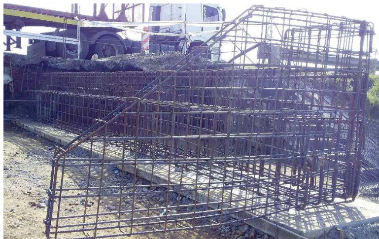
Imagen 14 – Armadura viga de estribo
