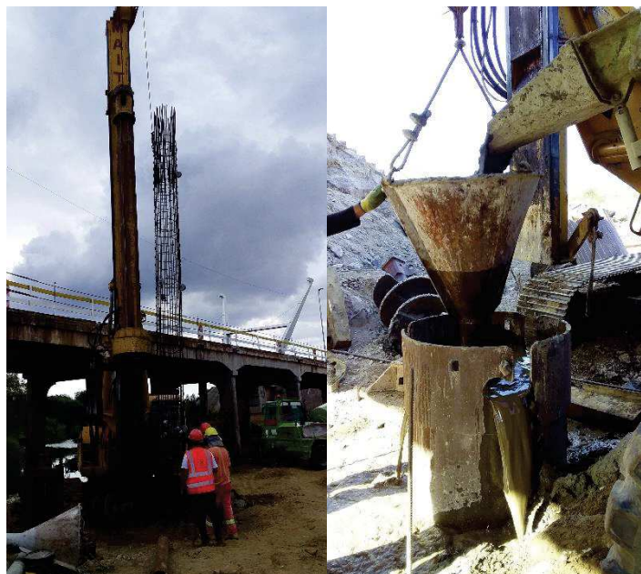
Imagen 8 y 9 – Colocación de armadura y llenado de pilotes mediante tubo Tremi
