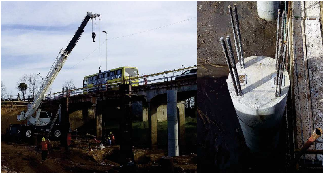
Imagen 10 y 11 – Construcción de pilares de 0,8m de diámetro mediante moldes metálicos
