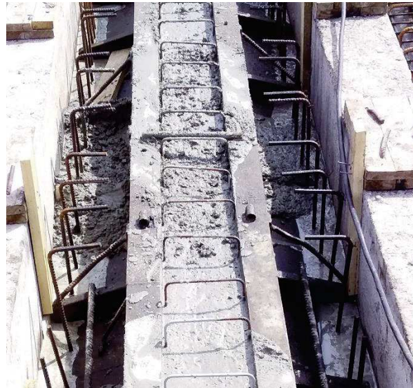
Imagen 2, 3 y 4 – Losetas pretensadas prefabricadas
