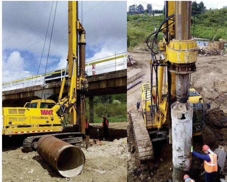
Imagen 6 y 7 – Perforación y puesta de camisas metálicas recuperables
