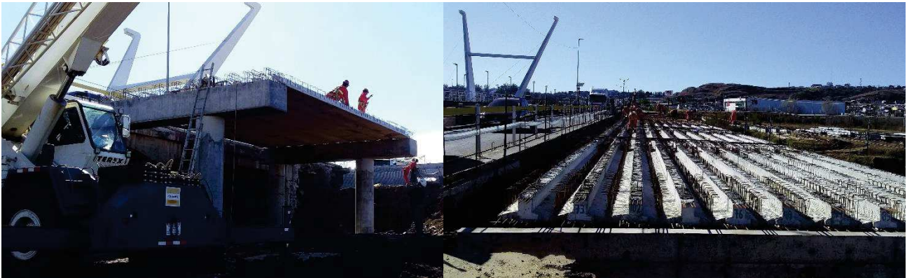
Imagen 19 y 20 – Montaje de losetas pretensadas
