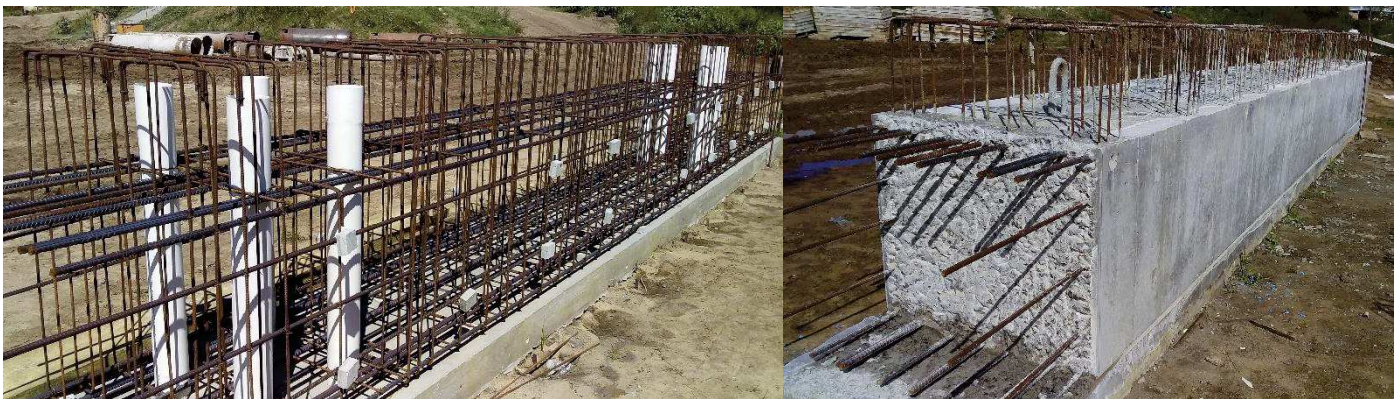
Imagen 15 y 16 – Vigas prefabricadas
