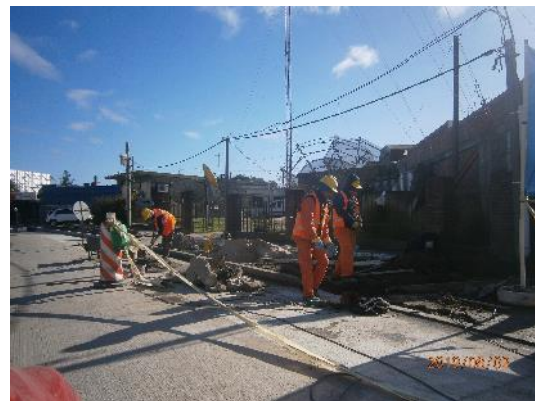
Ilustración 13 – Frente de obra
