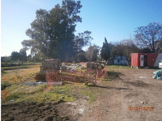
Ilustración 4 – Acopio de materiales de obra.
