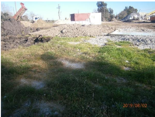
Ilustración 6 – Piletas de lavado con restos de material
