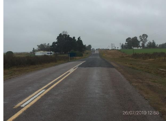
Ilustración 5 – Tramo terminado de obras sobre Ruta 6.
