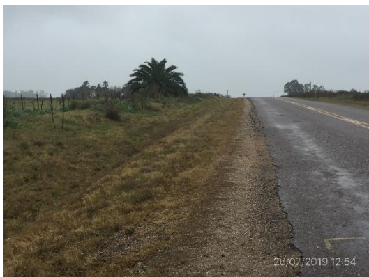
Ilustración 8 – Trabajos finalizados en Ruta 6
