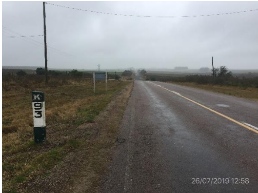
Ilustración 6 – Faja de obra con empastado realizado.
