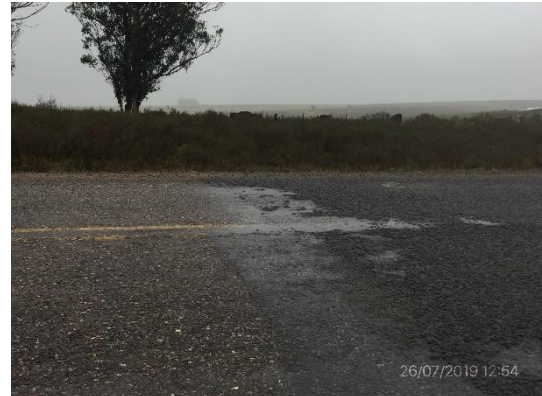
Ilustración 7 – Trabajos finalizados en Ruta 6, trabajos de bacheo
