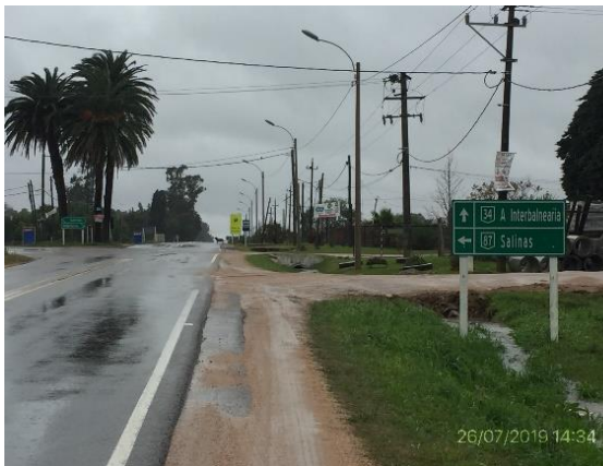
Ilustración 6 – P01, comienzo de tramo, ubicación de nueva rotonda a construir en empalme de Rutas 34 y 87.
