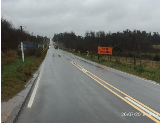
Ilustración 4 – Tramo de ruta 34 terminado.
