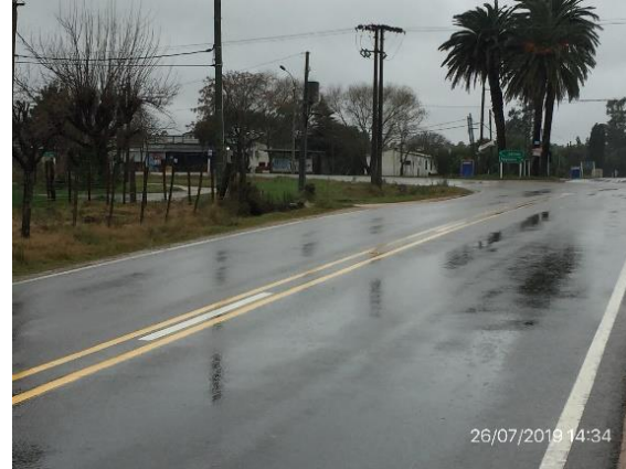
Ilustración 5 - P01, comienzo de tramo, ubicación de nueva rotonda a construir en empalme de Rutas 34 y 87.
