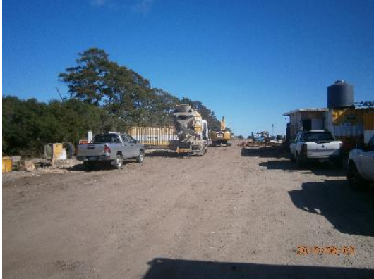
Ilustración 4 – Obrador de SACEEM
