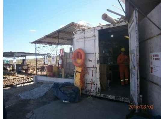
Ilustración 5 - Sector de acopio de productos químicos y pañol
