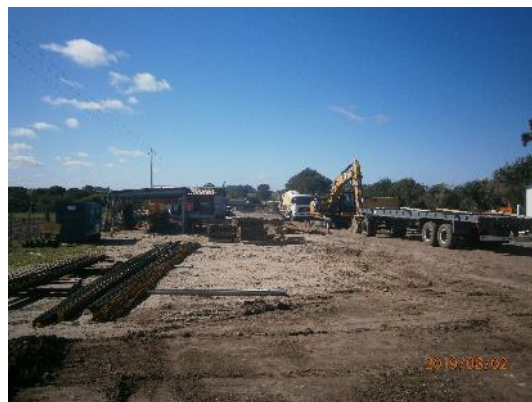
Ilustración 11 – Frente de obra
