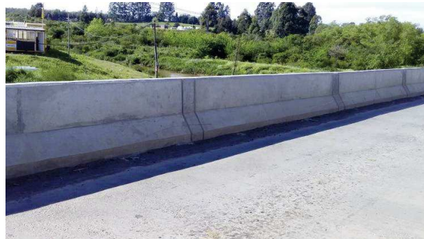
Imagen 7, 8 y 9 – Montaje y uniones de piezas
