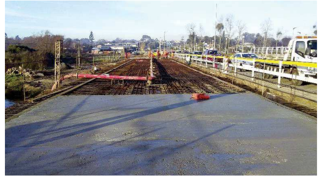
Imagen 2 y 3 – Armadura y llenado de talero
