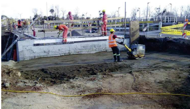
Imagen 10 y 11 – Construcción de losas de acceso
