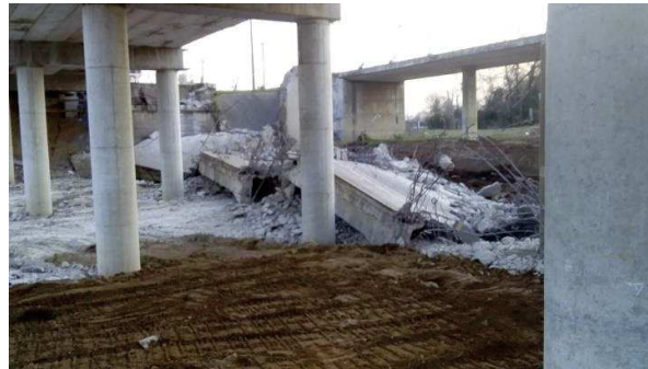
Imagen 12, 13 y 15 – Segunda etapa de demolición
