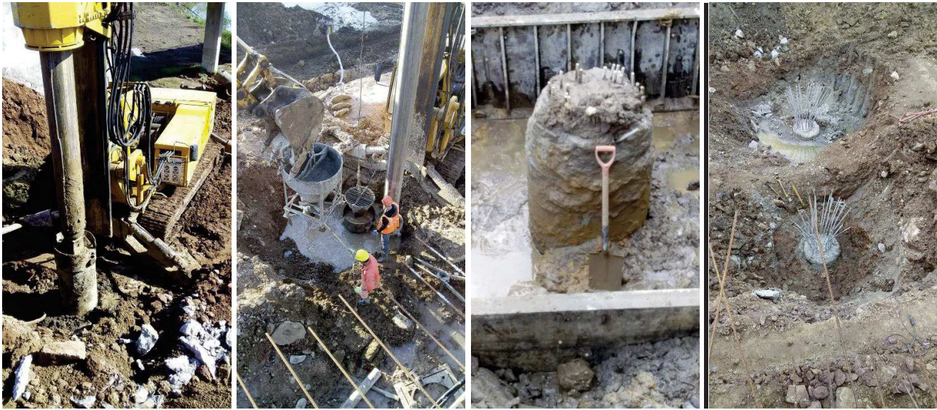
Imagen 16, 17, 18 y 19 – Perforación, hormigonado, limpieza para desmoche y pilotes desmochados
