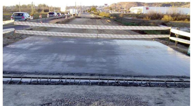
Imagen 10 y 11 – Construcción de losas de acceso
