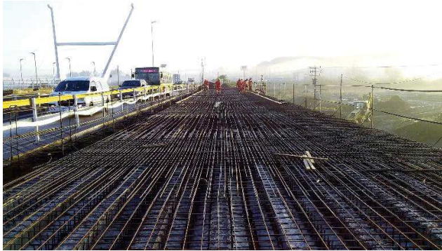
Imagen 2 y 3 – Armadura y llenado de talero
