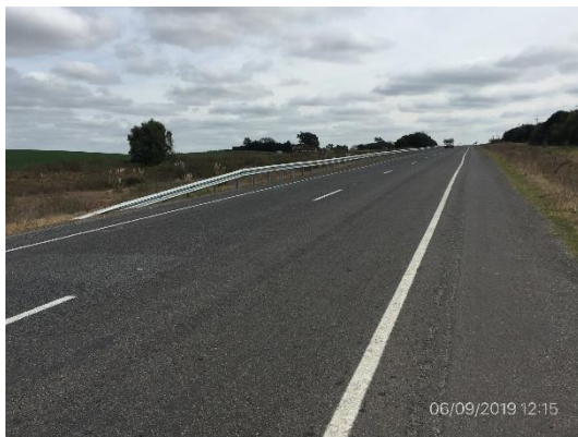
Ilustración 6 – Ruta 96, Obra terminada.
