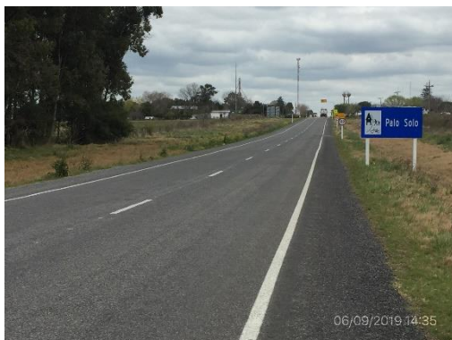
Ilustración 8 - Ruta 96, fin de tramo.
