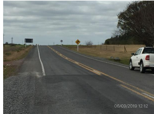
Ilustración 5 – Ruta 96, Obra terminada.
