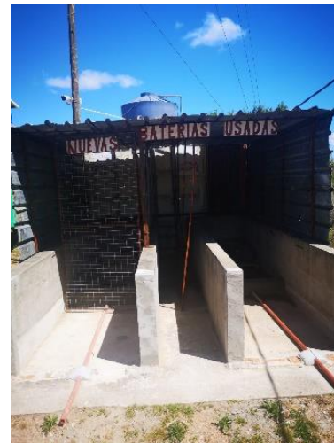
Ilustración 15 – Obrador Ruta 39 progresiva 20K600 a (-).Deposito de baterías.
