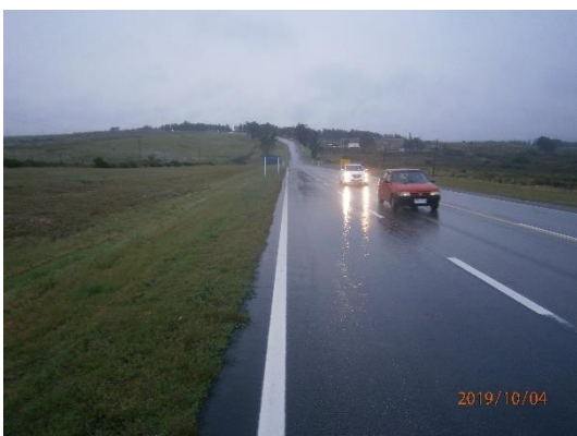
Ilustración 8 – Tramo de Obra Ruta 9
