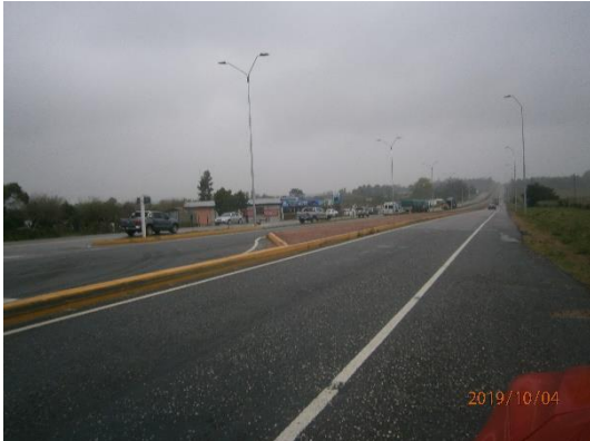
Ilustración 4 – Tramo de obra finalizada Ruta 8 Progresiva 183K000 pasaje por Mariscala
