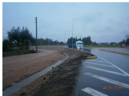
Ilustración 9 – Tramo de Obra Ruta 9
