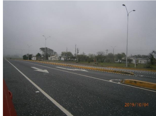
Ilustración 5 - Tramo de obra finalizada Ruta 8 Progresiva 183K000 pasaje por Mariscala
