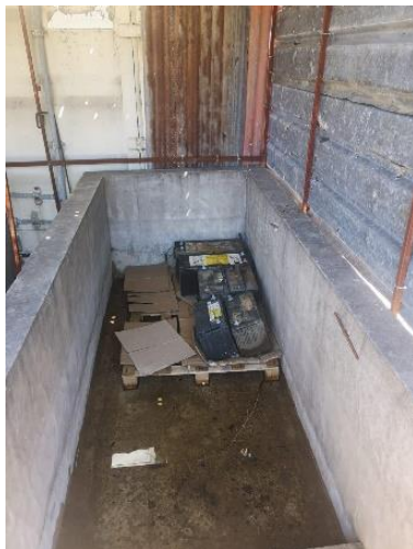
Ilustración 14 – Obrador Ruta 39 progresiva 20K600 a (-).Deposito de baterías.
