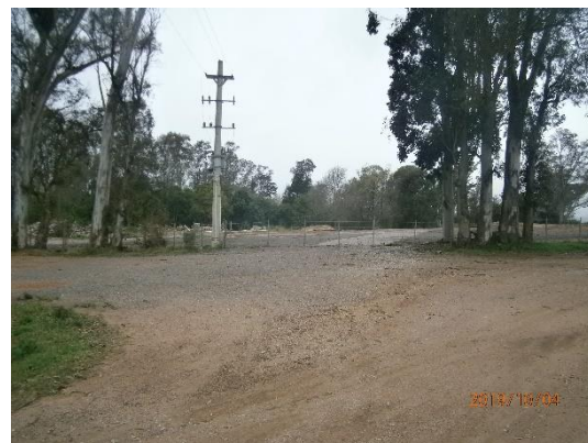
Ilustración 7 – Lugar donde estuvo emplazado Obrador ruta 8 progresiva 149K900
