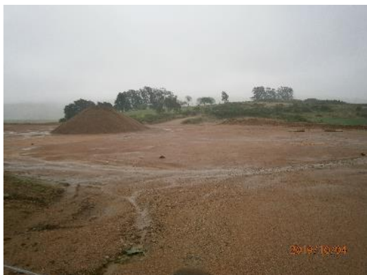
Ilustración 10 – Lugar donde funcionó cantera de materiales y Obrador secundario principal ruta 8 progresiva 366K500
