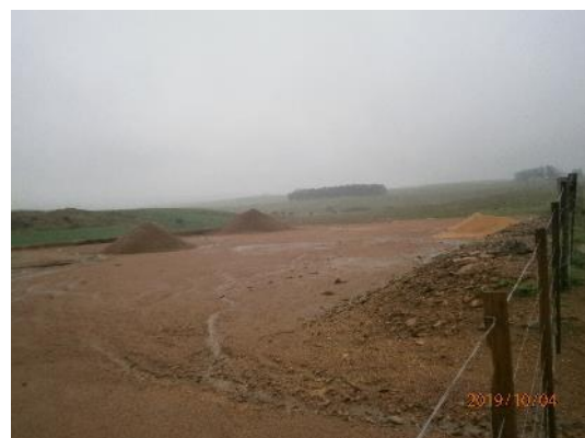
Ilustración 9 – Lugar donde funcionó cantera de materiales y Obrador secundario principal ruta 8 progresiva 366K500
