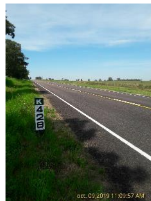
Ilustración 7 – tramo de ruta
