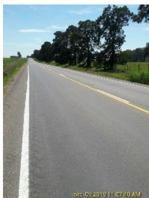
Ilustración 8 – tramo de ruta
