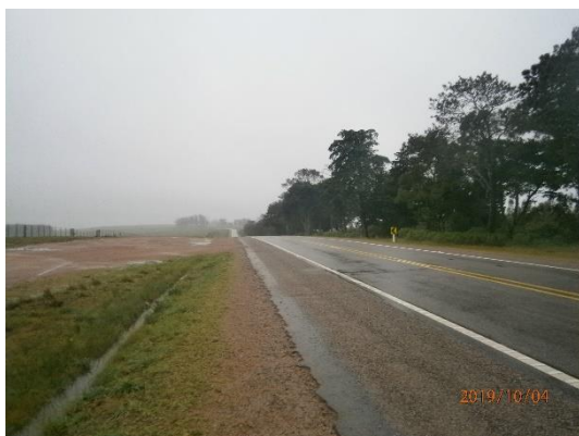
Ilustración 8 – Tramo de ruta
