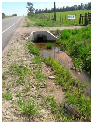
Ilustración 6 – tramo de ruta
