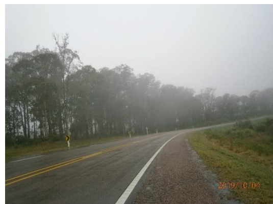
Ilustración 9 – Tramo de ruta
