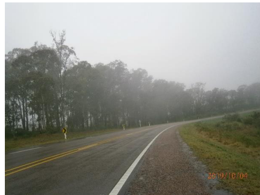
Ilustración 7 – tramo de ruta
