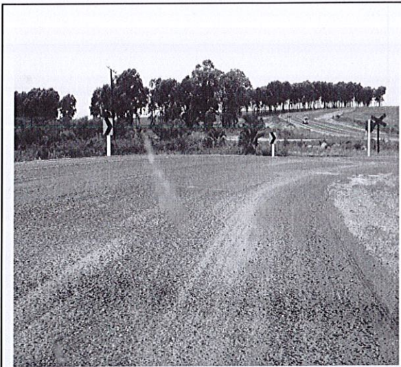
Material granular suelto sobre calzada.
