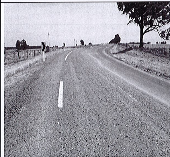
Material granular suelto sobre calzada.
