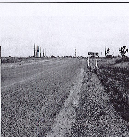
Señales de velocidad improcedentes, dos límites muy distintos. La señal reglamentaria discrepa con la de obra.
