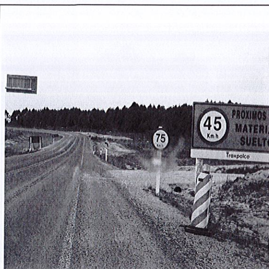
Señales de velocidad improcedentes, dos límites muy distintos. La señal reglamentaria discrepa con la de obra.
