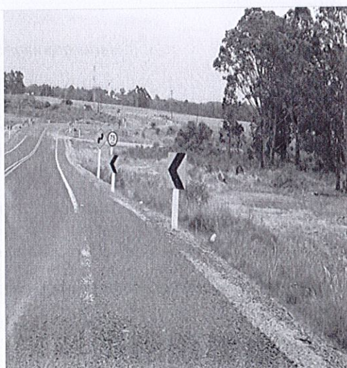
Señal de 75k/h cuando existe gravilla suelta.
